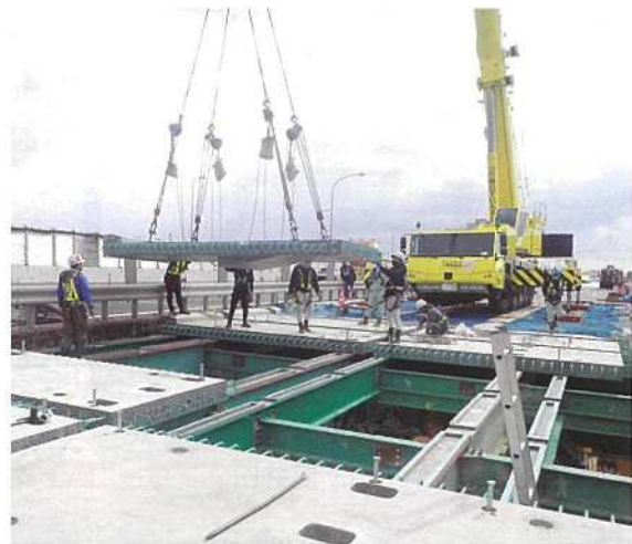
リニューアル工事実施状況
